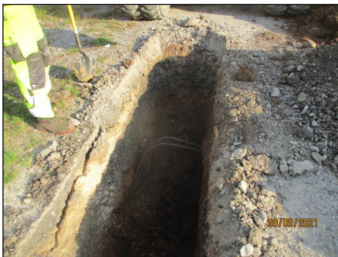
Bild 12: frei gelegte zwei Kraftstoffleitungen, Schurf 1
