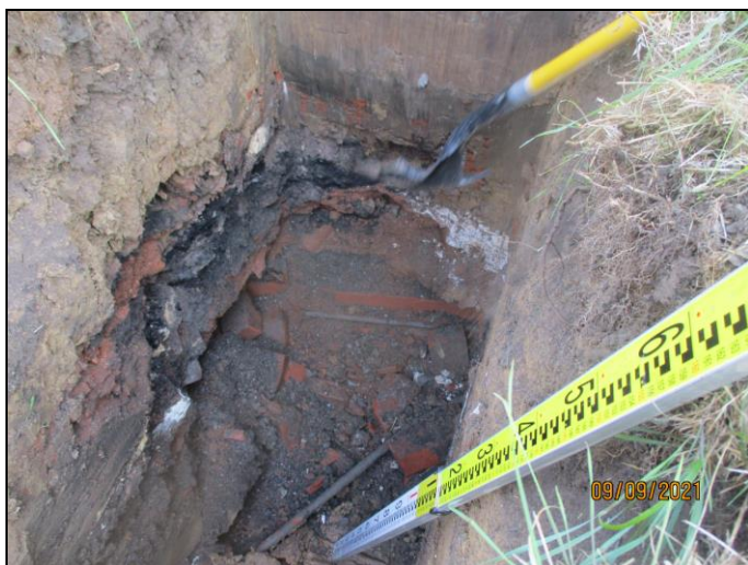
Bild 15: frei gelegte zwei Kraftstoffleitungen, Schurf 2
