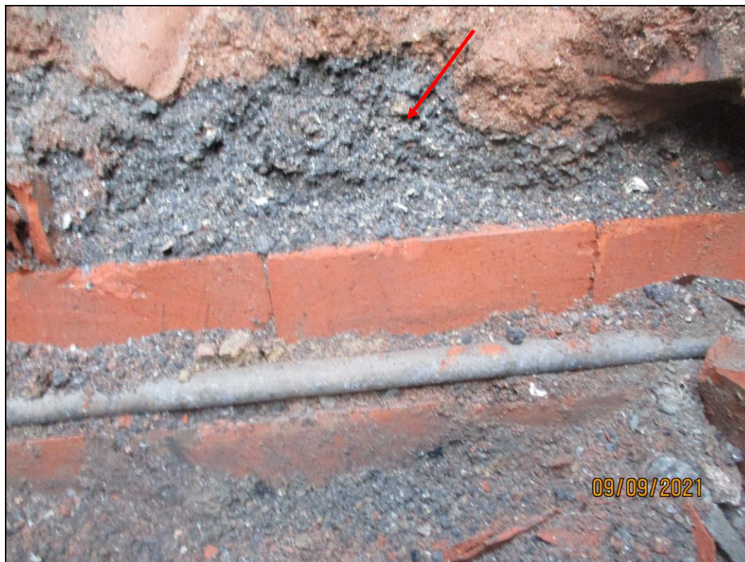
Bild 16: Blick „in“ den Leitungskanal aus lose aufeinander gesetzten Backsteinen, Pfeil: Kohle
